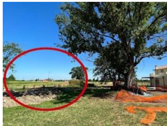
Fondamenta dell'Edificio 5 che sorgerà nell'area cerchiata
